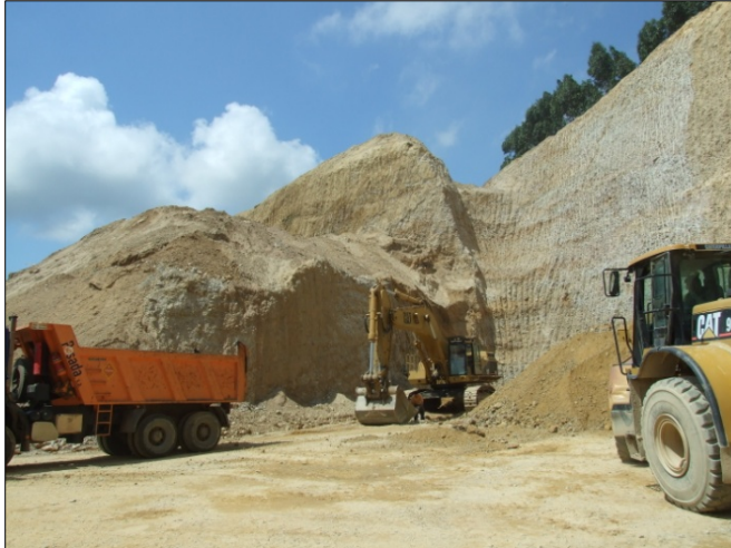
Fig. 3.7.13: Maquinaria típica utilizada para la extracción de conglomerados y arenas: Camión, retroexcavadora y pala cargadora frontal. Cantera “El Fontanón”.
