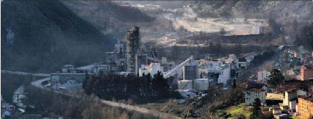
Fig. 4.2.7: Vista de la planta de fabricación de cemento y cal de Tudela Veguín (Oviedo) de la empresa Cementos Tudela Veguín.
