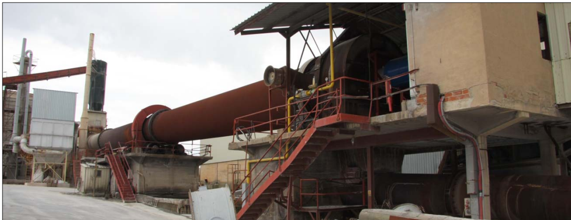
Fig.4.2.11: Instalaciones de calcinación. Tolva de almacén de caolín previo a su calcinación (en color verde al fondo), filtro de eliminación de gases y polvo del horno (color blanco a la izquierda), horno rotatorio (zona central en rojo) y tromel enfriador (a la derecha bajo la caseta de control).
