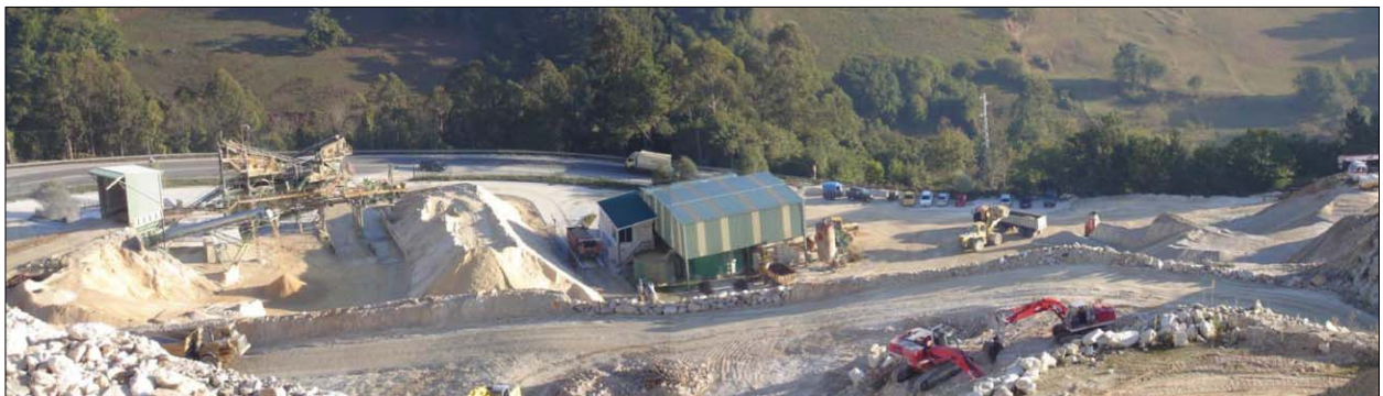
Fig. 3.3.11: Planta de tratamiento de la explotación “Manuela-Julia 2ª Ampliación” (n.º 252).
