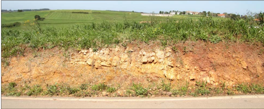
Fig. 3.12.2: Filón de barita en el talud de una carretera en las inmediaciones de Luanco (Est. n.º 475).
