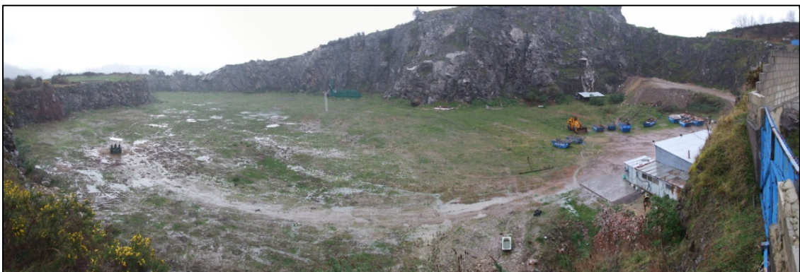
Fig. 3.1.5: Antiguo hueco de extracción de caliza utilizado en la actualidad como depósito de inertes. (Est. n.º 474).
