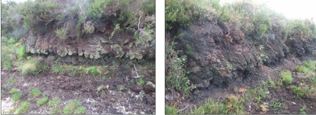
Fig. 3.12.33: Taludes de la explotación "Montserrat", donde es posible observar la totalidad de la potencia del yacimiento.
