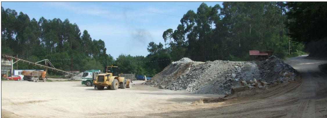
Fig. 3.9.4: Plaza de acopios de mineral, previo a su traslado a la planta de tratamiento de Torre, en "Mina Emilio".
