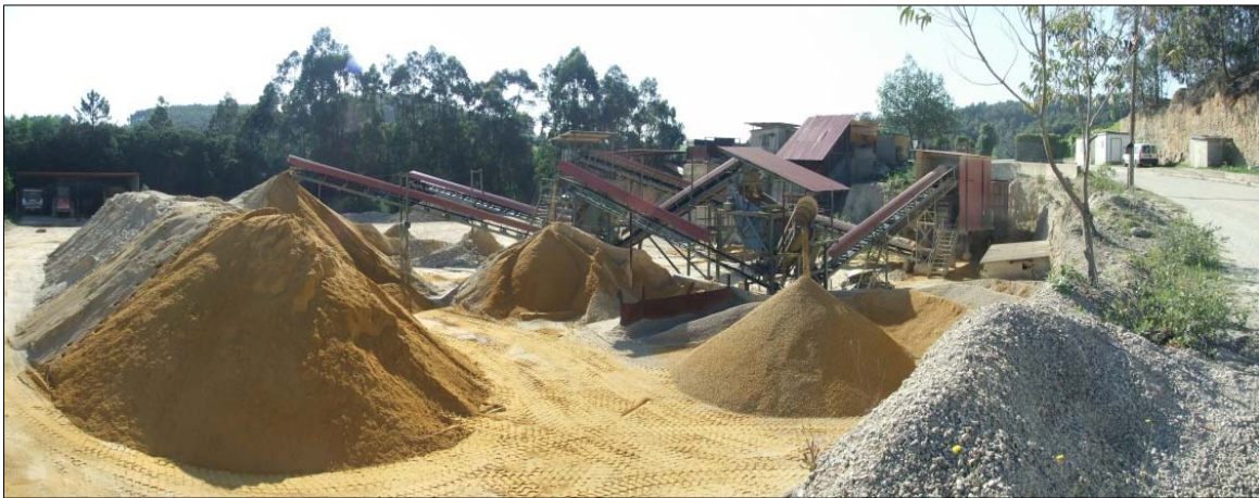
Fig. 3.7.14: Planta de tratamiento de conglomerado y arenas. Cantera “La Rebollada”
