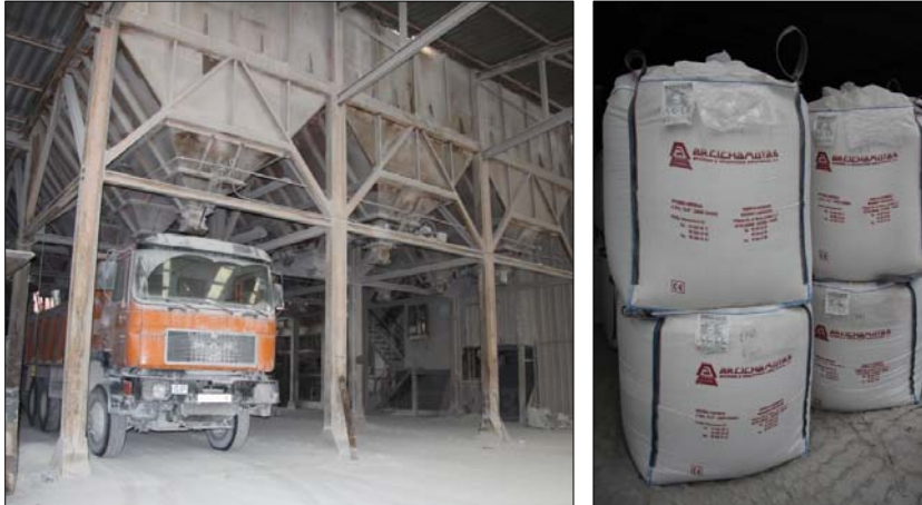
Fig. 4.2.13: Expedición del material a granel en camiones y en “big-bags” para su venta.
