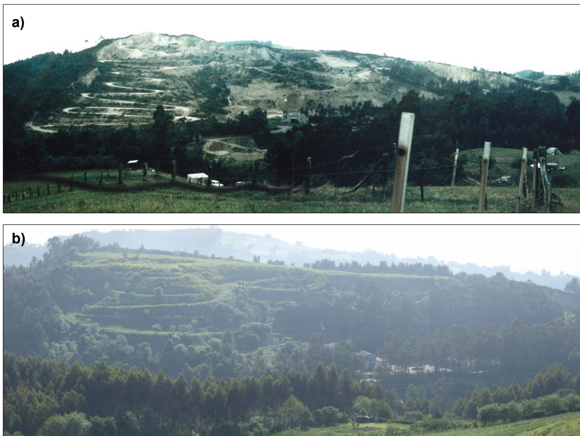
Fig. 3.7.20: Cantera del Monte Pica (Est. n.º 534). a) Aspecto de la explotación en el año 1985. b) Aspecto en el año 2011, tras su restauración.
