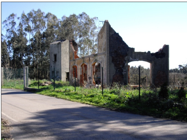
Fig. 3.12.19: Restos de las instalaciones asociadas a la “Mina Rucao”.
