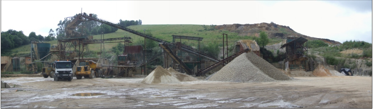
Fig. 4.2.2: Planta de tratamiento de conglomerados y arenas de la Fm. Pola de Siero de la cantera “La Carba”.
