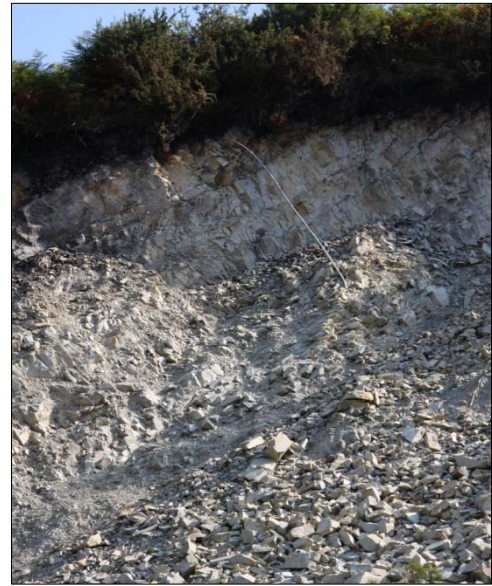
Fig. 3.3.2: La alta fracturación de la roca beneficia la extracción de material. Estación n.º 870, Cangas de Onís.
